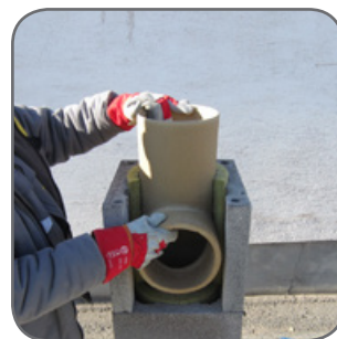
9.4 Behelyezzük a csatlakozót
