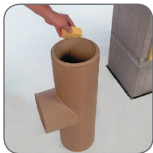
9.2 Megtisztítjuk a füstcső-csatlakozó csővégeit.
