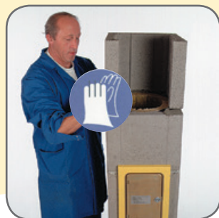
8.3- 8.4 A nyílással ellátott köpenytéglát felhelyezzük. A felesleges habarcsot lehúzzuk, a nyitott felfekvésű hézagokat teljesen eltömítjük. Meghajlítjuk és behelyezzük a szigetelő lapokat. Az első szellőztető csatornákat szabadon kell hagyni, ezért a hőszigetelő lapot le kell vágni.
