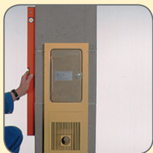
7.2 A kéménytalpat függőlegesen a habarcsba állítjuk.
