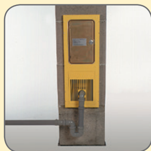
7.3 Kialakítjuk a kondenzvíz elvezetését és a csatornába kötöttetjük.
