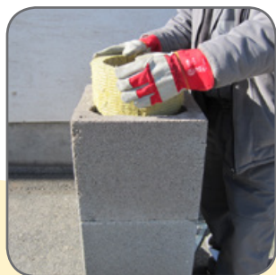
6.2 A szigetelő lapot meghajlítjuk és behelyezzük.
