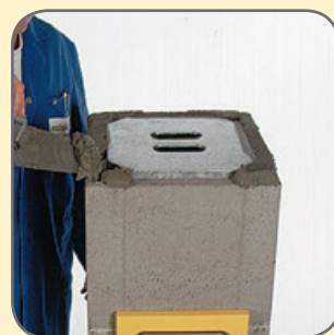
7.4 A habarcs-sablon segítségével habarcsot hordunk fel a kéménytalp tetejére. A sarokfuratokba ne kerüljön habarcs.
