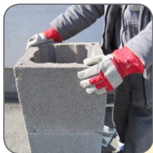
6.1 A köpenytéglát a habarcs-terítésbe helyezzük
